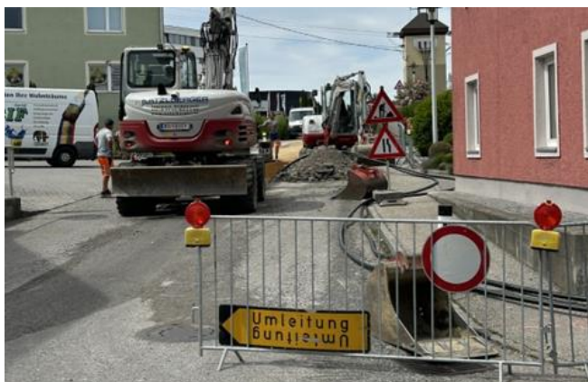
Baustellen wie diese stören natürlich, sind aber unvermeidlich
