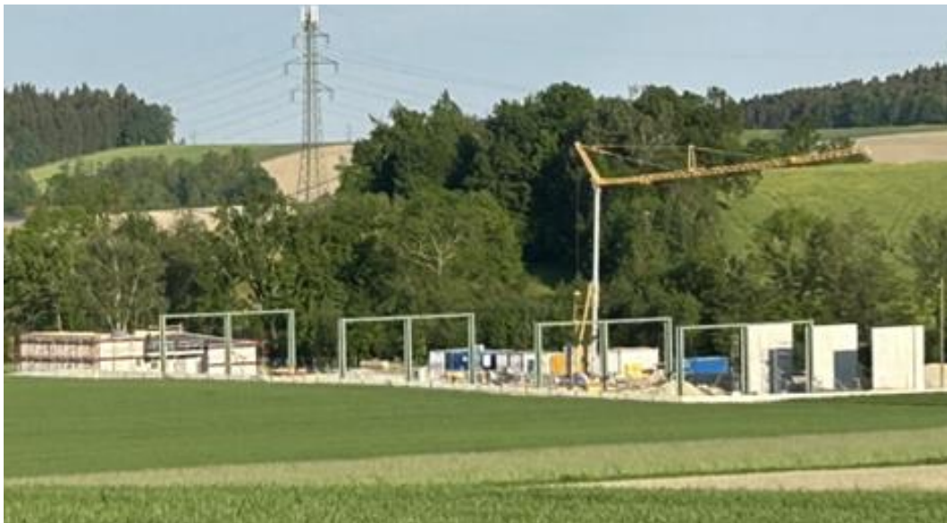
Die Baustelle des Umspannwerks Fertigstellung Herbst/Winter
